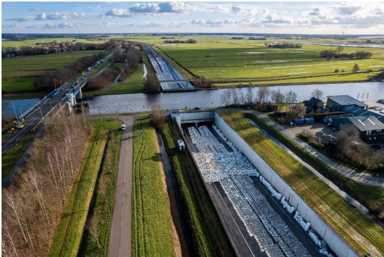
Foto 3 Big bags zorgen ervoor dat tunnelmoot weer in positie komt (bron: Rijkswaterstaat)
