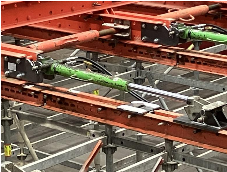
Foto 13 Verplaatsen van het platform gebeurt met een hydraulisch systeem (bron: PERI)
