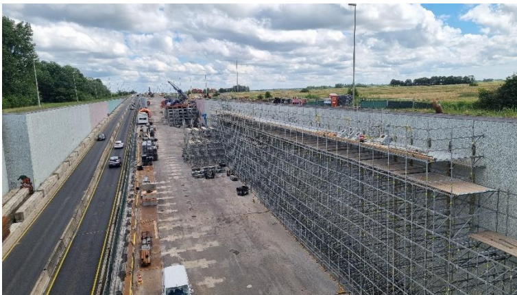
Foto 16 Voorbouwsteiger met in de verte werkplatform (bron: Jacques Linssen)
